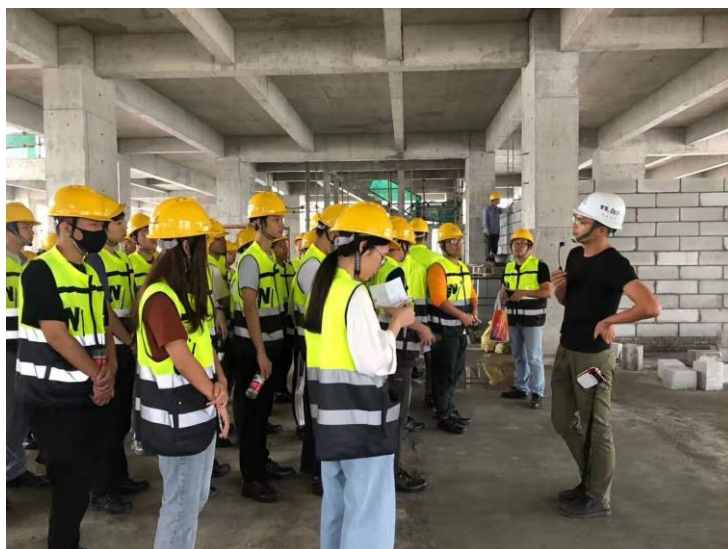
图 3.8 建筑工程技术“双元班”项目现场实践
